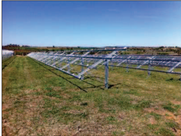
Photo 1 : Exemple de structures fixes
