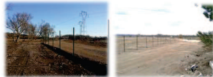
Exemple de pose de panneaux grillagés rigides
