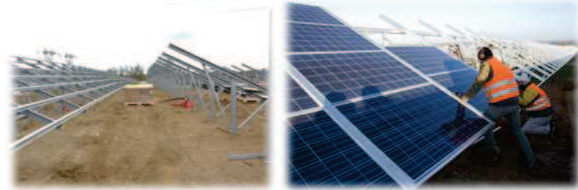
Montage des structures et pose des panneaux
