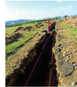
Photo 3 : Tranchée pour câblage
