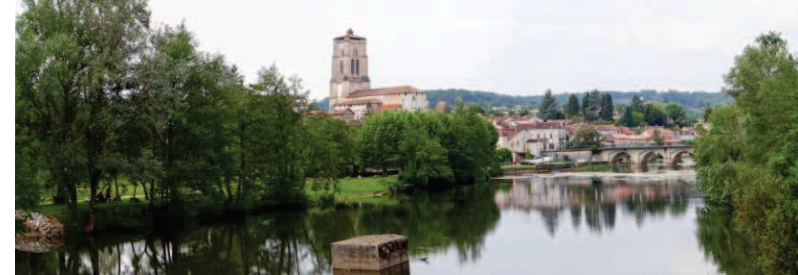
Voie de communication principale entre Périgueux et Bordeaux, la vallée de l'Isle a connu un développement urbain important. Le bourg de St-Astier, implanté en bord de rivière.
