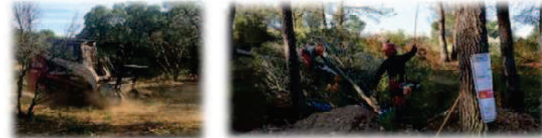
Exemple d'opérations de débroussaillage
