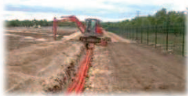
Enfouissement des réseaux
