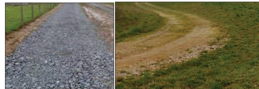
Exemple de chemins d'exploitation
