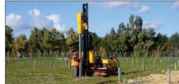
Figure 4. Sonnette de battage hydraulique
