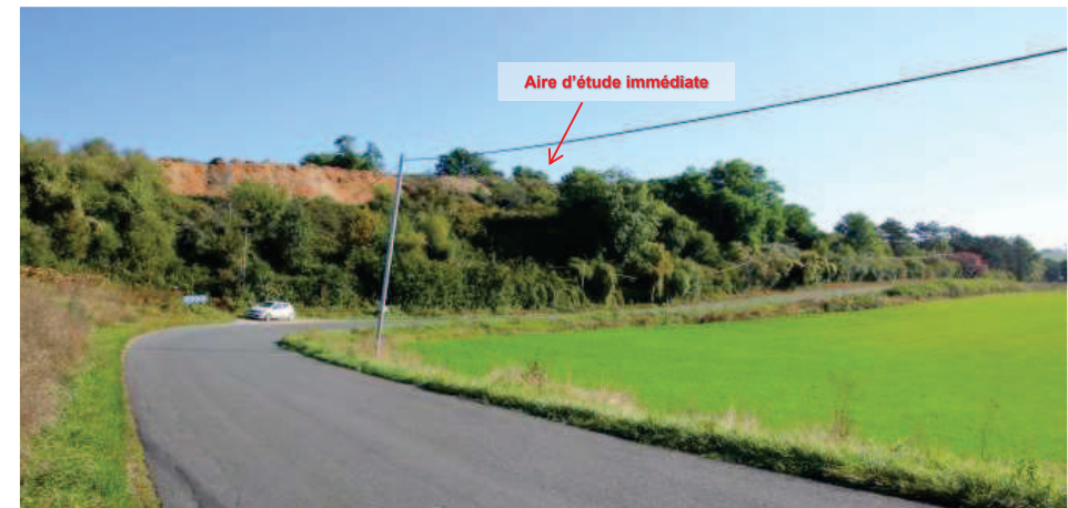
Photo 18 : La RD113 bordant l'aire d'étude immédiate au Sud
