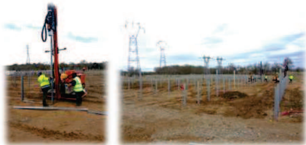
Mise en place des pieux battus
